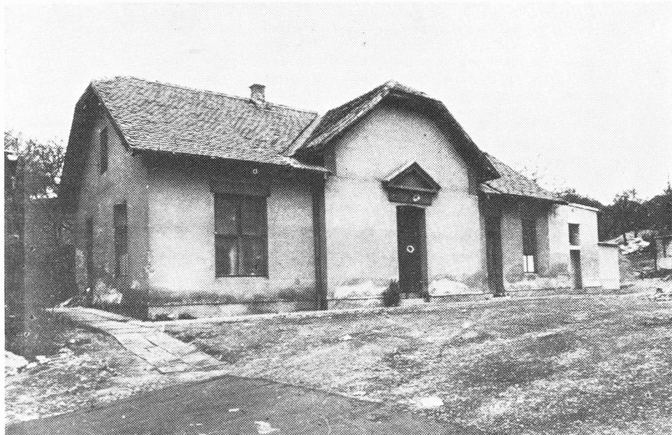
Stara dotrajala zgrada prosekture Zavoda za patologiju u vrijeme prije njena rušenja.
