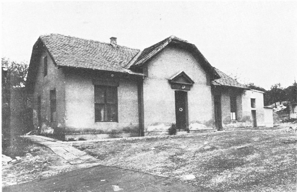
Stara dotrajala zgrada prosektura Zavoda za patologiju u vrijeme prije njena rušenja.
